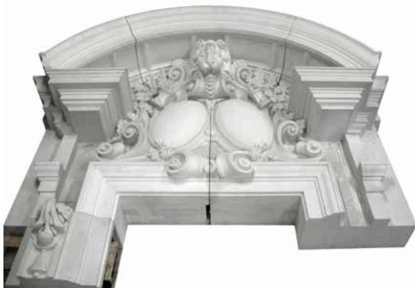
8. ábra | Honvéd Főparancsnokság – rekonstrukció, szegmensíves ablakszemöldök szobrászdszék tagozatok modell / ALAKart 2024
