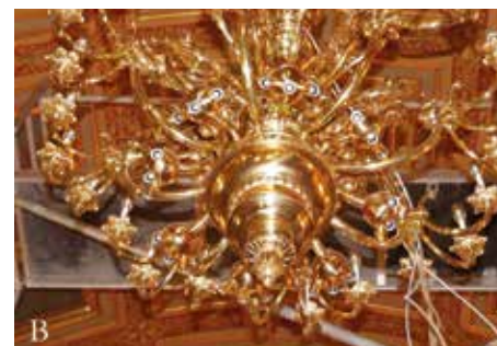
14. ábra | Kiegészítő világítás elhelyezése az Operaház két csillárjában. A. Az alsó kosár áttörésein kivilágító minireflektorok; B. Külön elemekbe helyezett fényforrások / a szerző fotója
